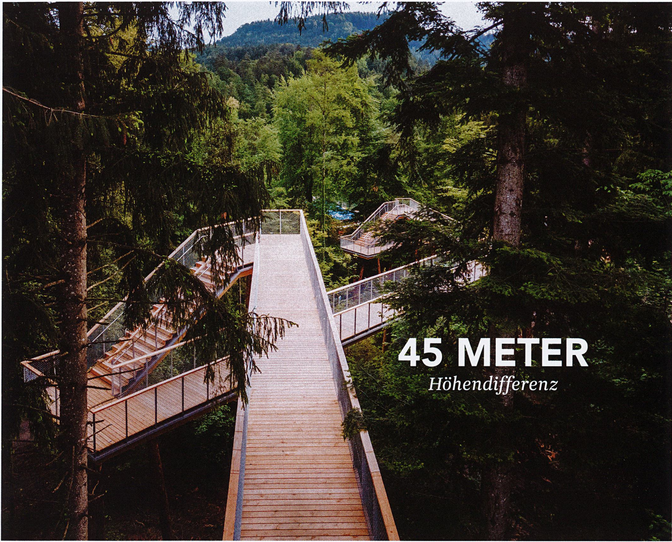
Die Wegschlaufen überwinden jeweils drei Meter Höhe. Der Steg ist angenehme 1,80 Meter breit und aus Baarer Douglasienholz gefertigt.
