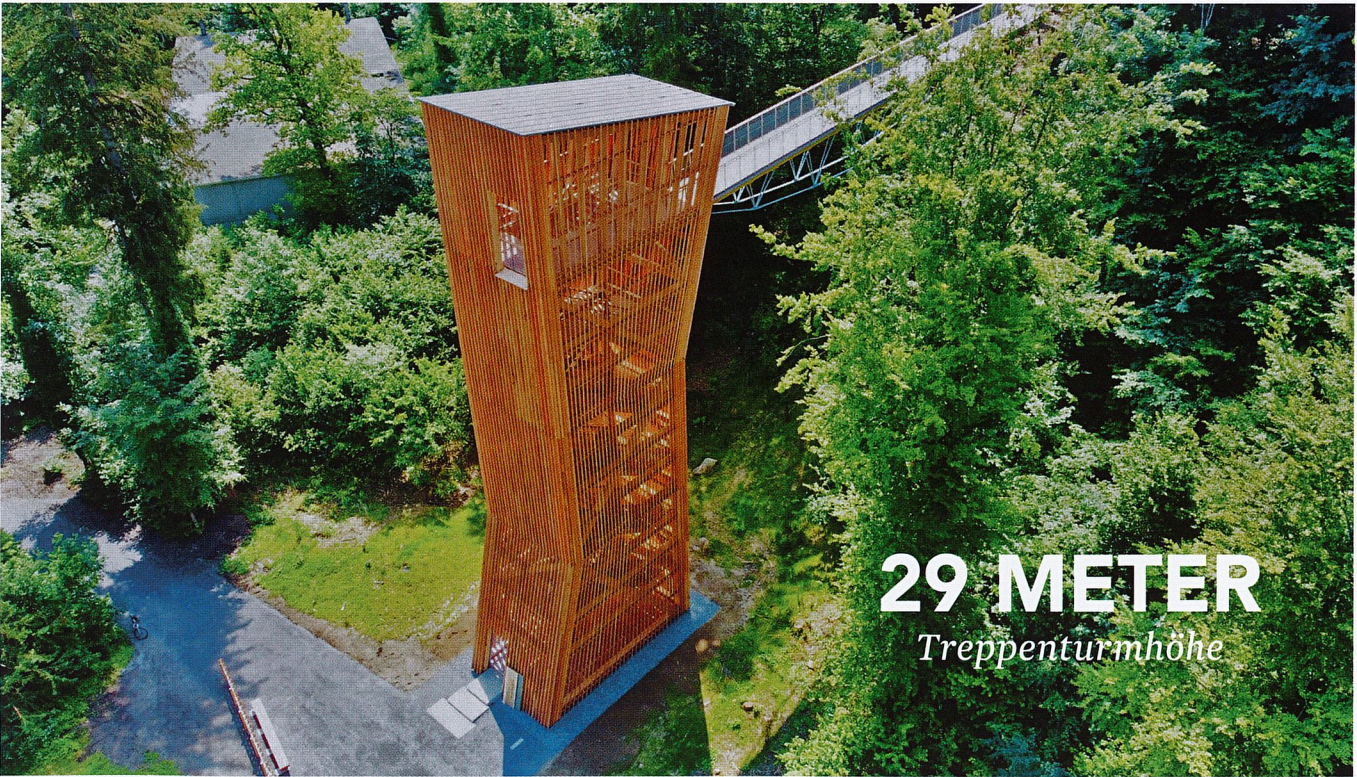
Ebenso mit Douglasienlamellen eingefasst ist die Treppenkonstruktion aus Brettschichtholz.
